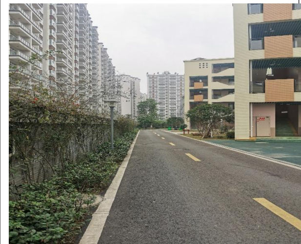
道路及场地硬化现状照片 02
