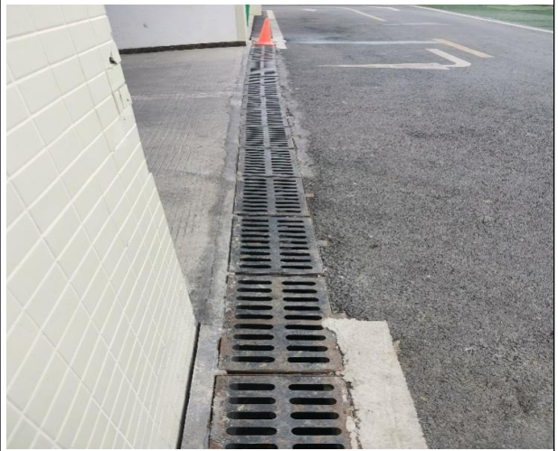
预制盖板排水沟 02
