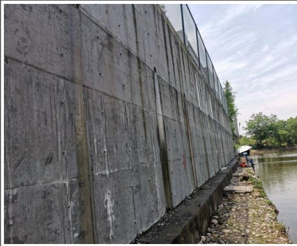
外围挡土墙现状照片 01
