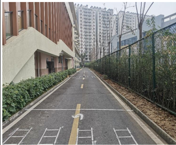
道路及场地硬化现状照片 01
